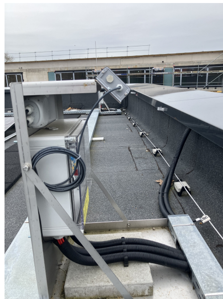
(b) Foto des nördlichen Einstrahlungssensors. © Thorsten Kühn, HZB
