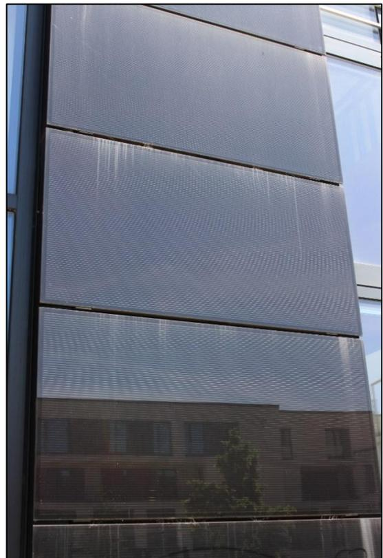
Abbildung 28: Detailansicht Solarmodule Solteature Firmengebäude (Quelle: eigene Darstellung)
