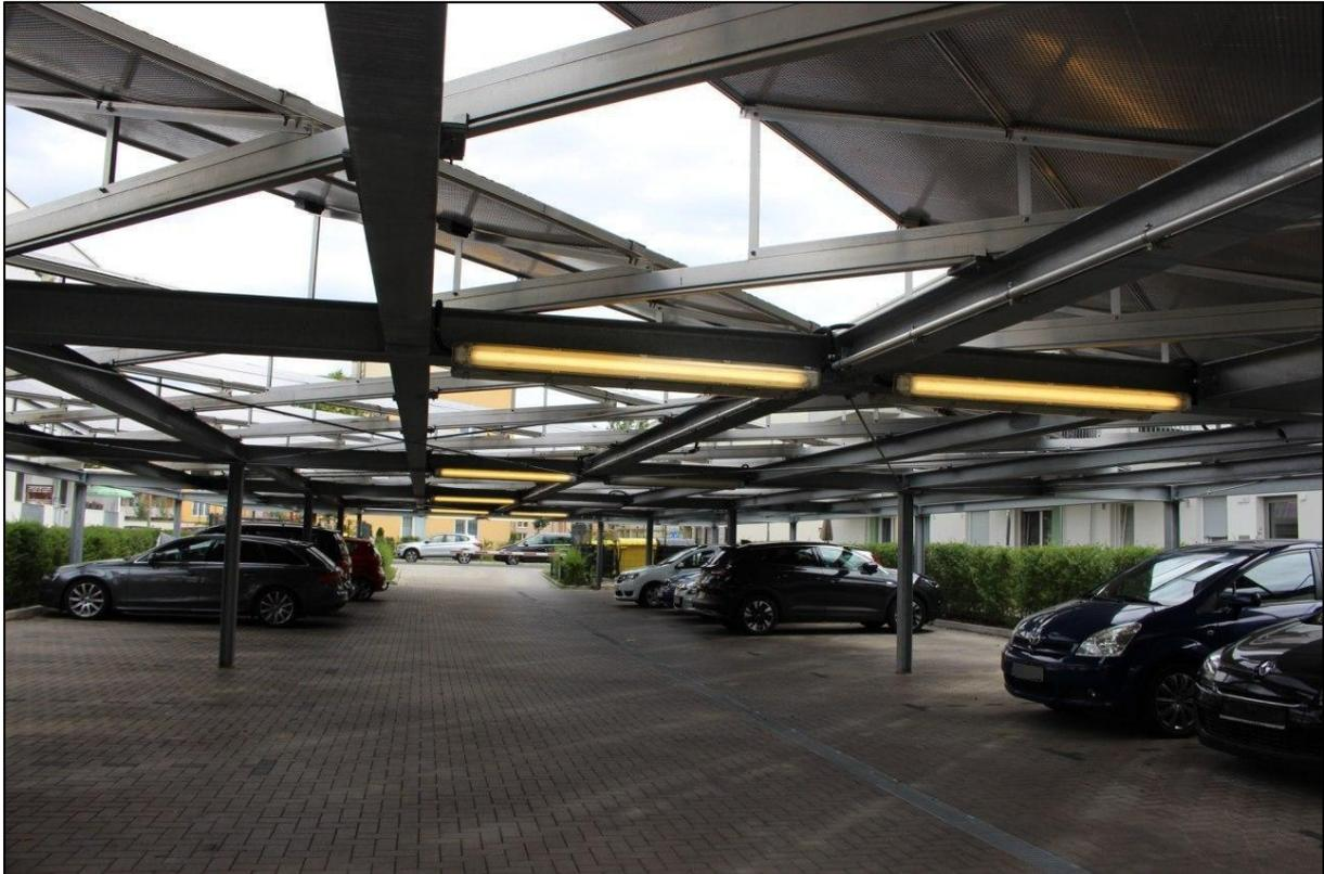
Abbildung 21: Detailansicht Stahlkonstruktion Parkplatzüberdachung (Quelle: eigene Darstellung)
