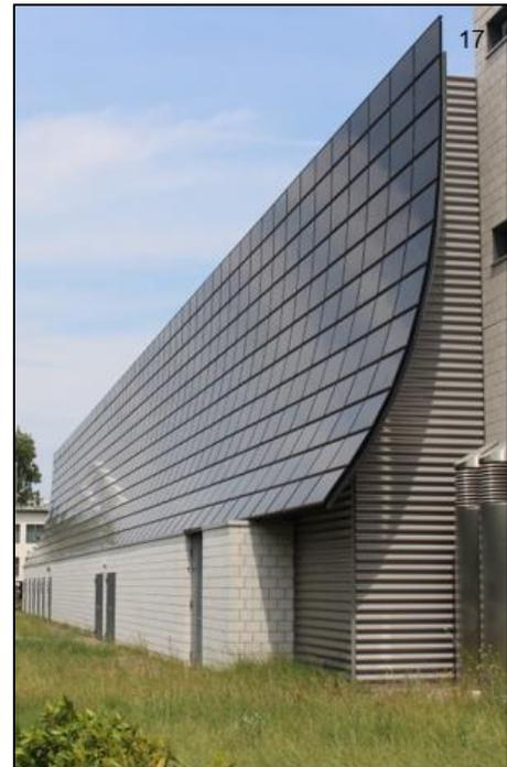
**Art der Anlage:***Fassadenanlage***Inst. Leistung:***39,1 kWp***Modulanzahl:***732***Inbetriebnahme:***2006*
