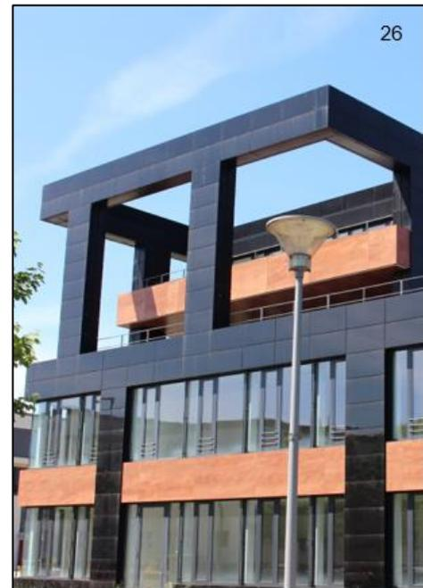
**Art der Anlage:***Fassadenanlage***Inst. Leistung:***20 kWp***Modulanzahl:***900***Inbetriebnahme:***2009*
