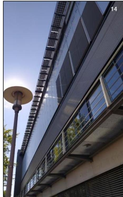
**Art der Anlage:***Sonnenschutz***Inst. Leistung:***4,45 kWp***Modulanzahl:***unbekannt***Inbetriebnahme:***2010*
